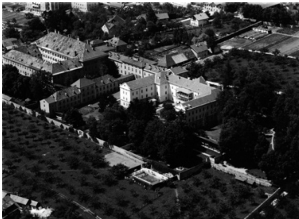
Landesnervenkrankenhaus Hall i. T. 1960, westlicher Gebäudekomplex
