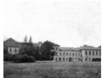
Ansicht der alten Anstalt (links das Frauenhaus, rechts neben dem Mitteltrakt das Männerhaus mit Verwaltungsgebäude)
